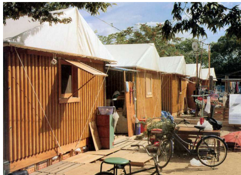
Paper Log House, sont des maisons en carton réalisées par Shigeru Ban en 1995 pour répondre au séisme de Kobe au Japon.
