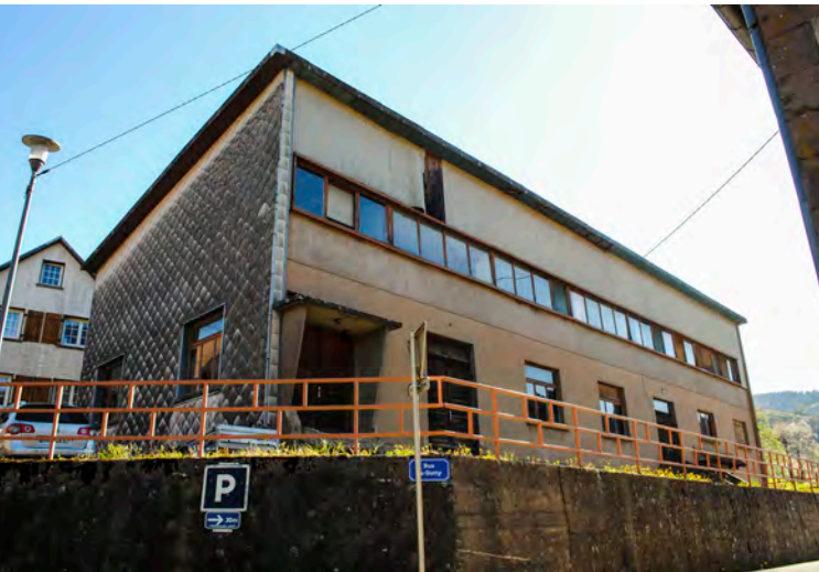
Extérieur du foyer paroissial
