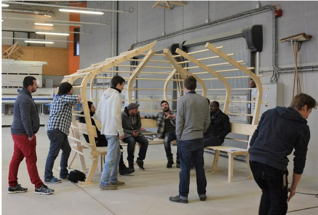
Fabrication de la charpente, en épicéa massif et lamellé-collé, à l'atelier des Compagnons du Devoir de Muizon. © Chaire IDIS
