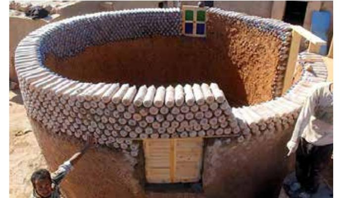
Fig. 17 Construction d'un habitat avec 6 000 bouteilles plastique
