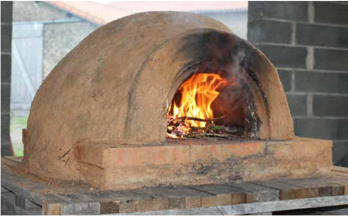
Fig.27 Four en terre crue Source: Idée d'en faire
