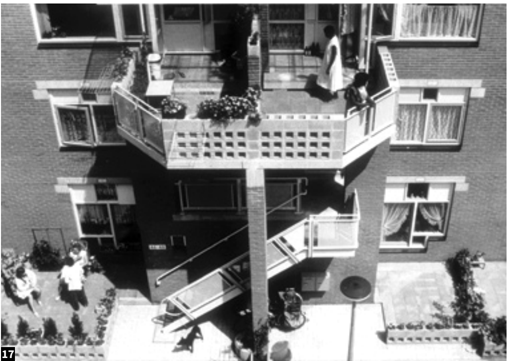
15/ Jeanne GANG, Aqua Tower , Chicago, 2010. Vue d'ensemble de la tour de logement. 16/ Aqua Tower . Vue des balcons 17/ Herman Hertzberger, Haarlemmer Houttuinen , 1985, Amsterdam
